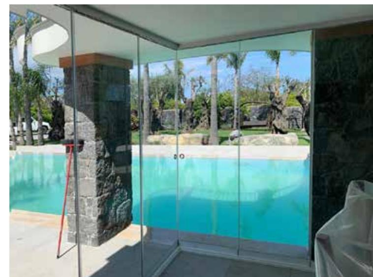
La configuration avec angle permet d'installer les sections à 90° avec la possibilité d'utiliser les rails supplémentaires afin d'augmenter le nombre de vantaux et choisir l'ouverture latérale ou centrale.
